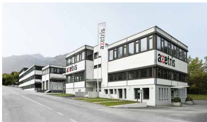
Leister Technologies AG, Production, Kaegiswil, Suisse
