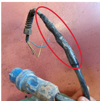
Použití poškozeného kabelu
