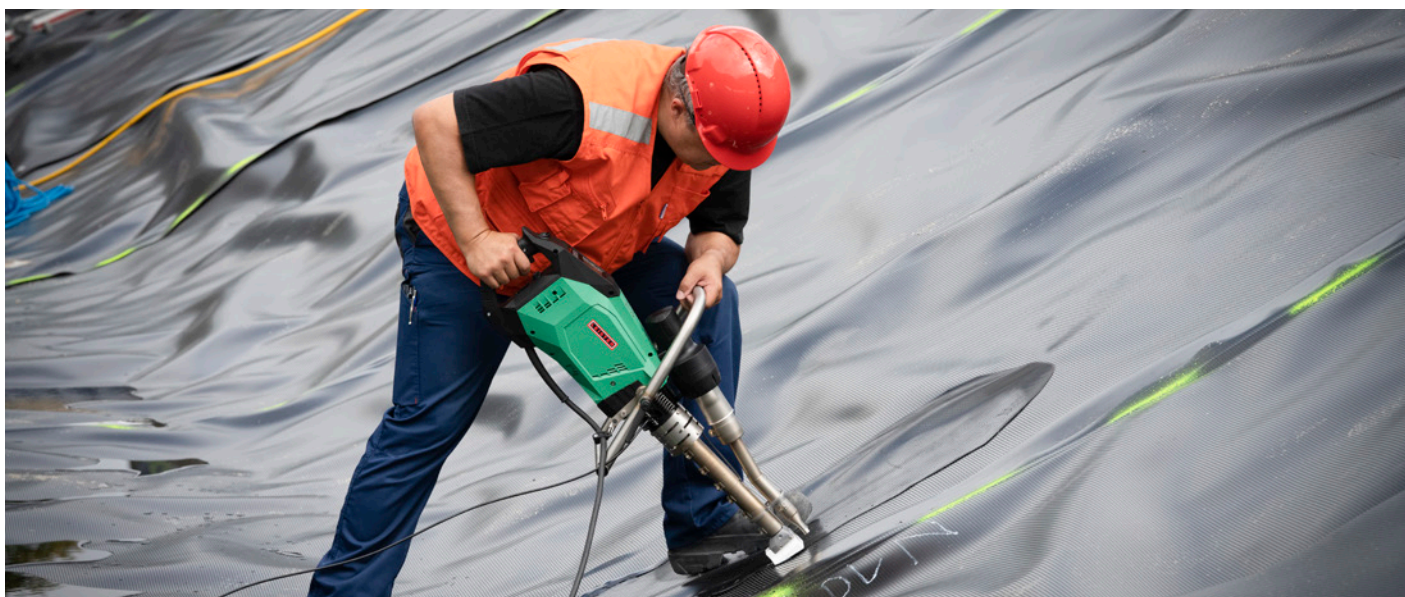
Soudage par extrusion d'une bande d'étanchéité en PEHD pour bassin réalisé à l'aide d'une extrudeuse WELDPLAST 605 de Leister
