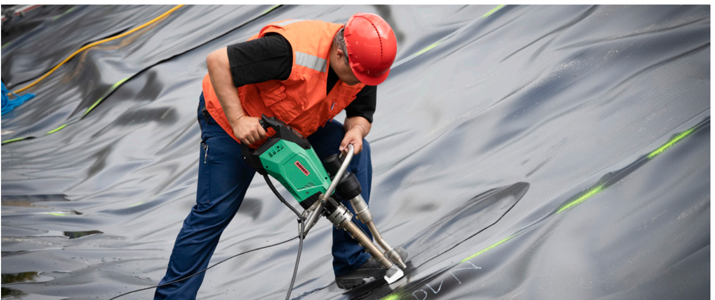
Extrusionsschweissen einer HDPE-Dichtungsbahn mit dem Leister-Extruder WELDPLAST 605 in einem Teich
