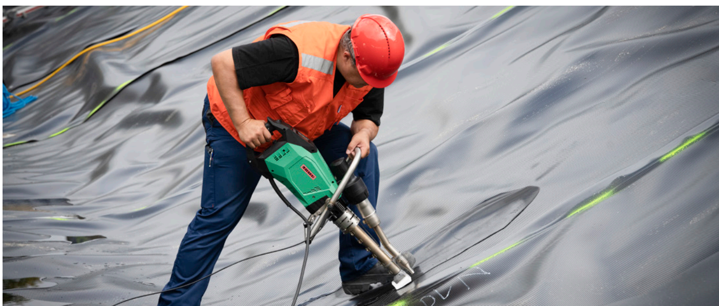
Saldatura ad estrusione di un foglio di tenuta in HDPE con l'estrusore Leister WELDPLAST 605 in un bacino
